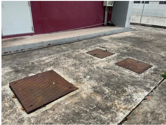
ภาพที่ 13 บ่อพักน้ำทิ้ง ขนาด 75 ลบ.ม.
