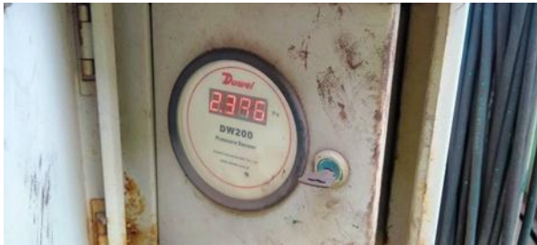
ภาพที่ 3 อุปกรณ์ตรวจวัดความดันในระบบดักฝุ่น แบบแผ่นกรอง
